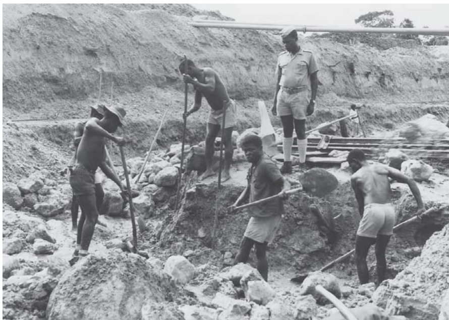
Figura 45 - Desmonte de cascalho na exploração da mina Sunza/Chilupuca, vigiado por um capataz. 1966
