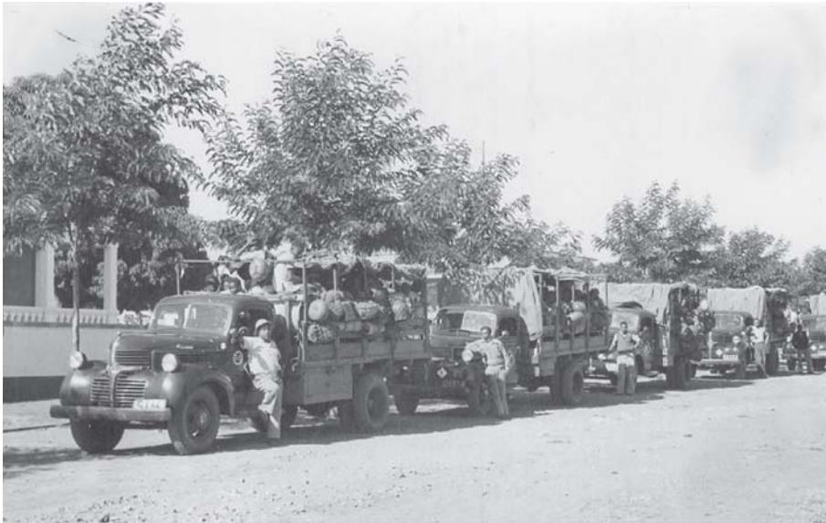
Figura 40 - S/L [Camiões para o transporte de trabalhadores contratados] 1948
