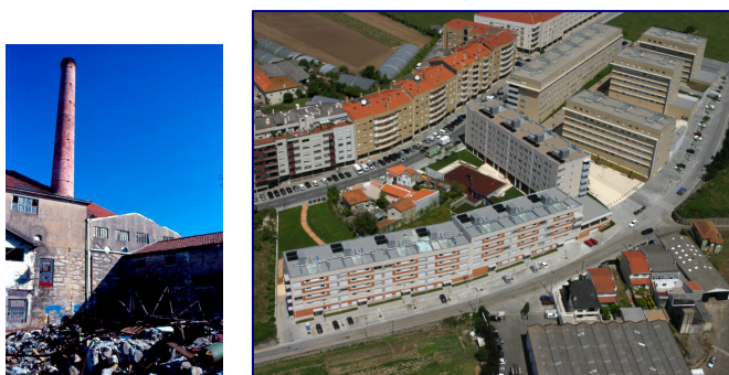
Fig. 11. Antiga fábrica e novo empreendimento da Ponte da Pedra (1ª e 2ª fase)
