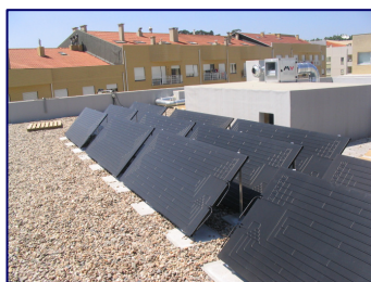
Fig. 12. Painéis solares e aparelho de aquecimento solar e de gás dos apartamentos
