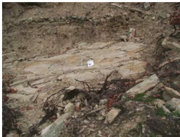
Fig.9 - Alvações do Corgo – importância dos planos de estratificação que coincidem com a superfície de deslizamento
