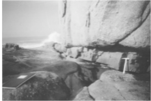
Figura 3 – Granito de Lavadores e o aplito mais resistente á erosão marinha.
