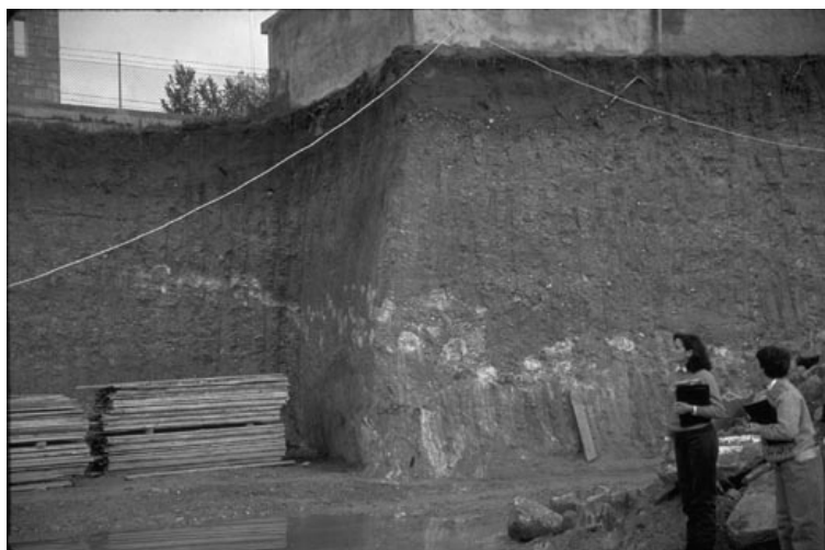
Figura 6. Base do depósito da Fase II englobando blocos dos depósitos da Fase I (fundações do Centro Comercial, Candal – Vila Nova de Gaia).
