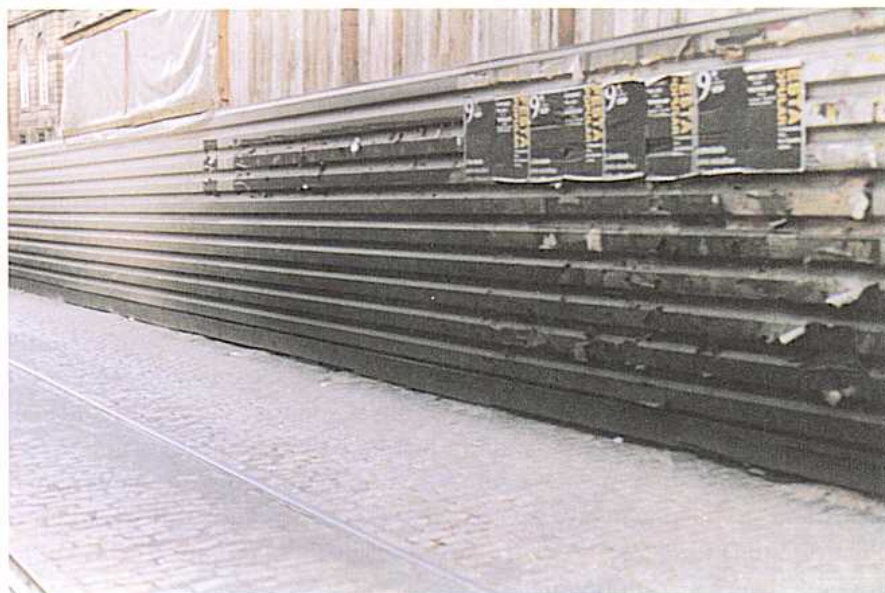
c) Cor das barreiras de protecção das obras do Hospital Geral de Sto. António, cerca de seis meses após a sua colocação (1/1/93).
